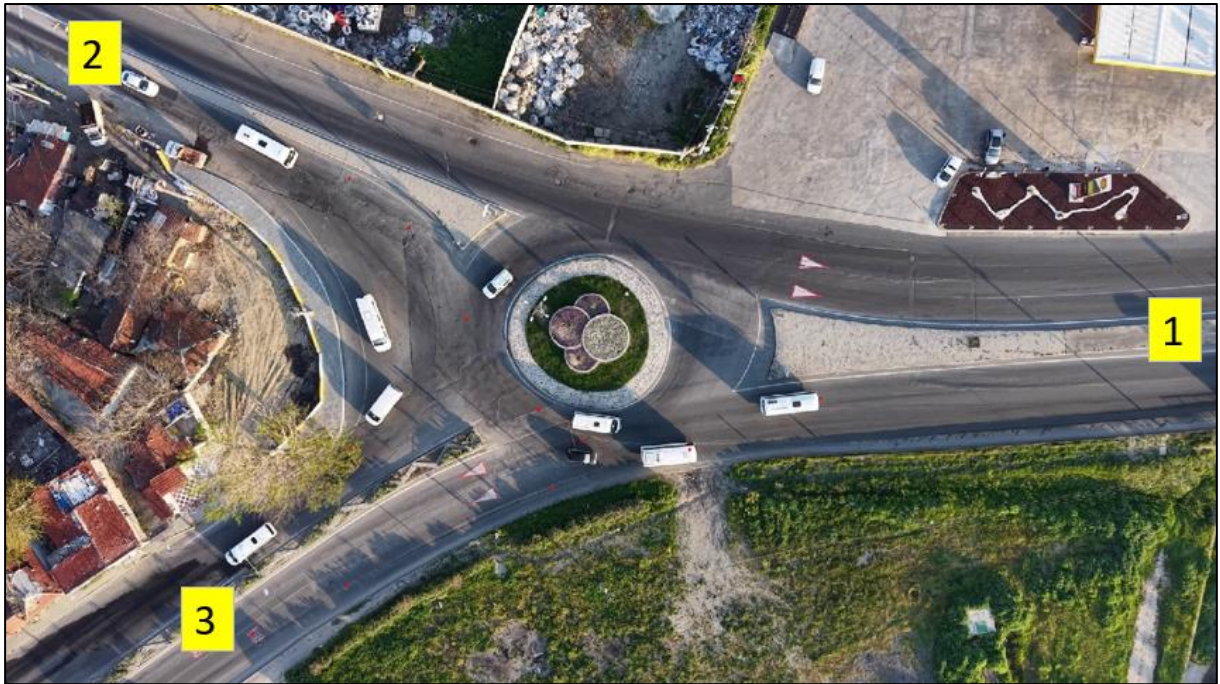
Şekil 31. ÇK.16.01 Kavşağı Drone Görüntüsü
