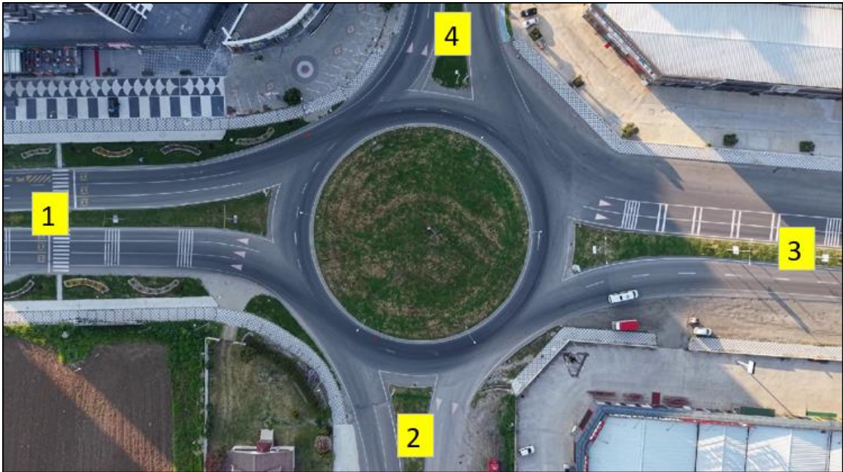
Şekil 5. ÇK.02 Kavşağı Drone Görüntüsü
