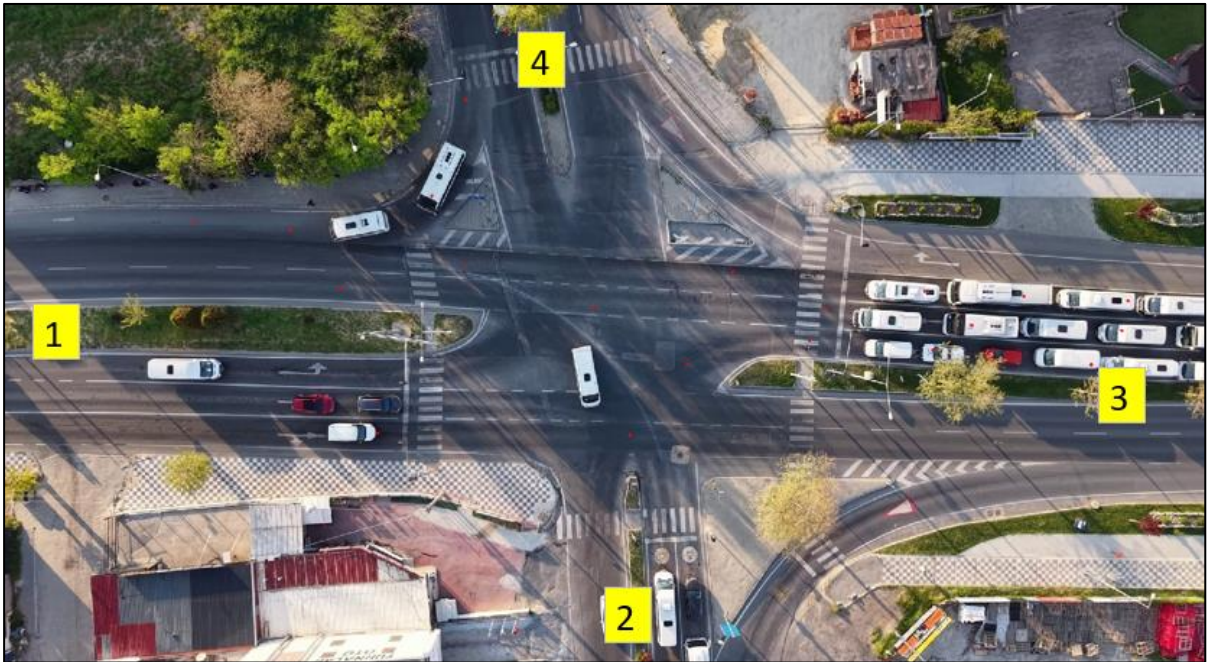
Şekil 3. ÇK.01 Kavşağı Drone Görüntüsü
