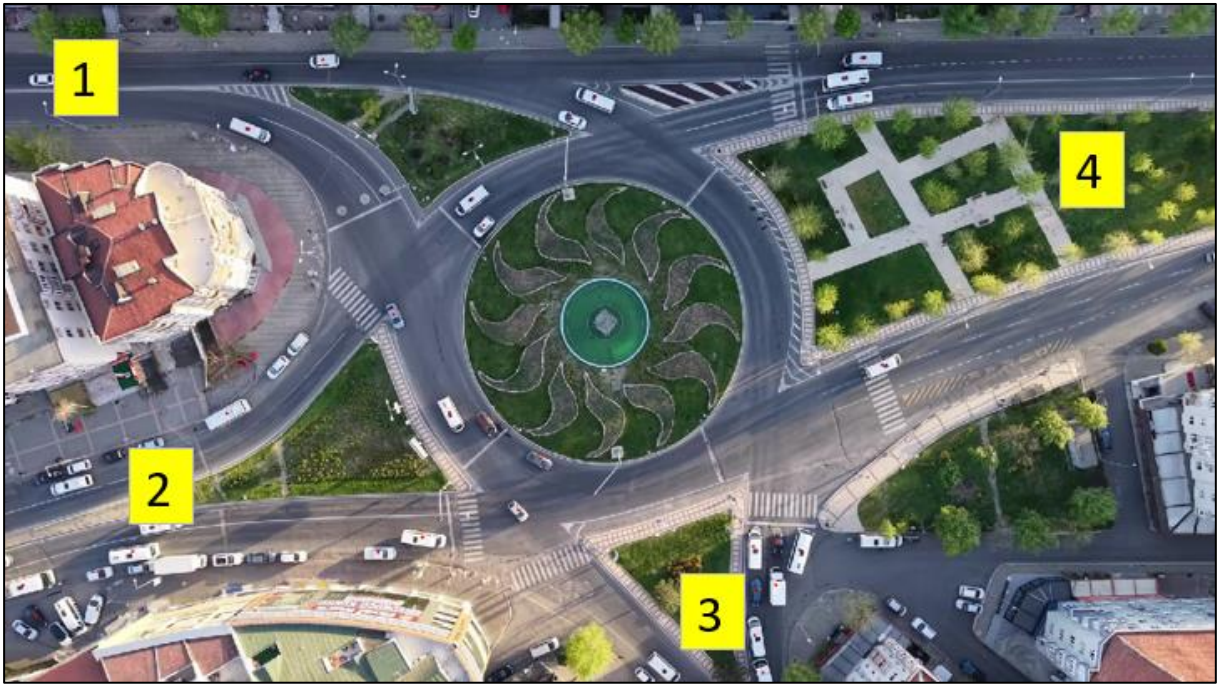
Şekil 25. ÇK.13 Kavşağı Drone Görüntüsü
