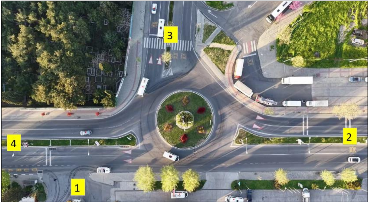
Şekil 37. ÇK.20 Kavşağı Drone Görüntüsü
