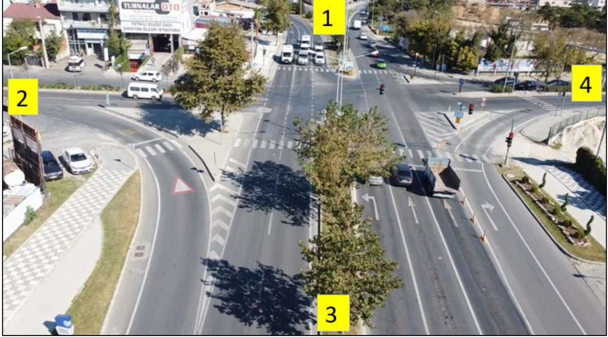
Şekil 3. Endüstri Meslek Kavşağı Yaklaşım Kolları Görüntüsü-2
