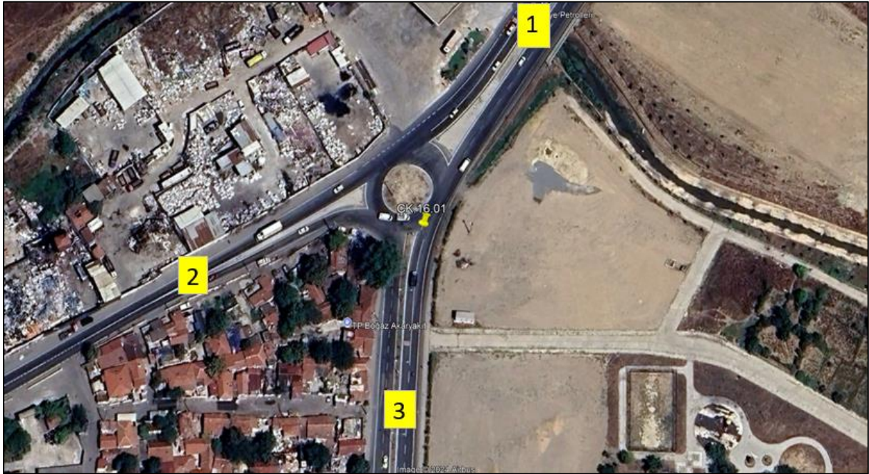
Şekil 92. Çerkezköy Giriş Kavşağı Yaklaşım Kolları Görüntüsü-1
