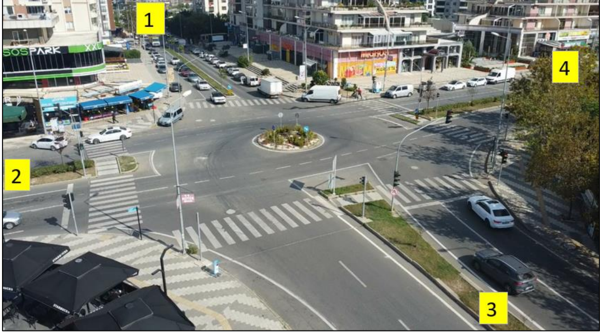
Şekil 103. Çamlıbel Kavşağı Yaklaşım Kolları Görüntüsü-2
