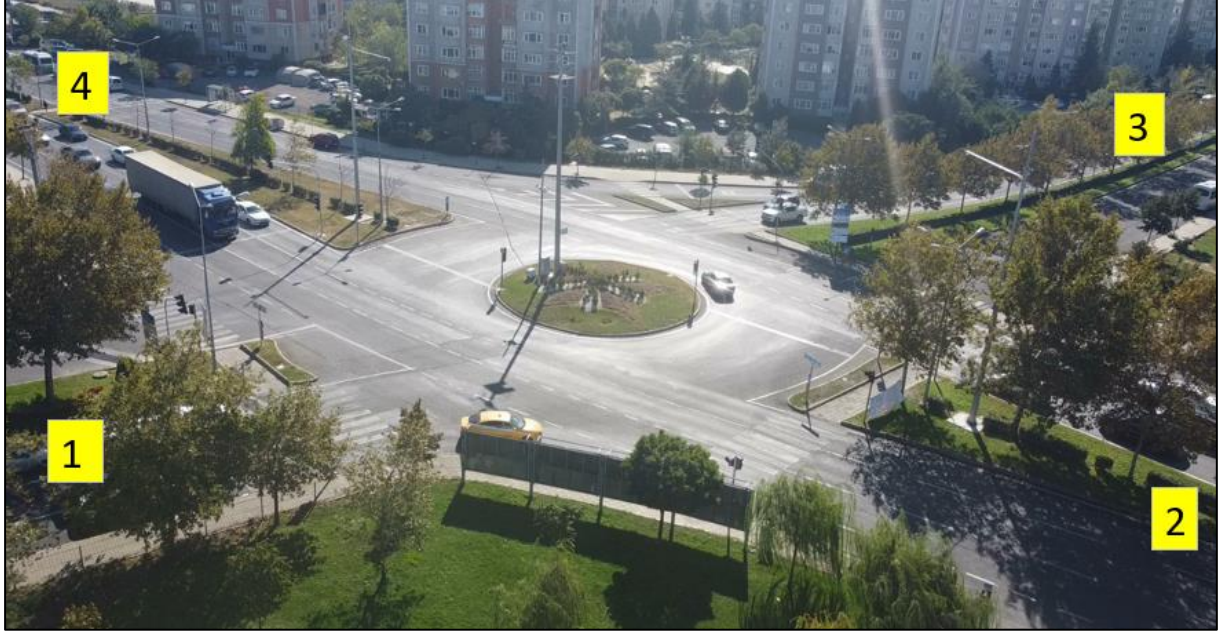
Şekil 23. Belediye Konutları Kavşağı Yaklaşım Kolları Görüntüsü-2
