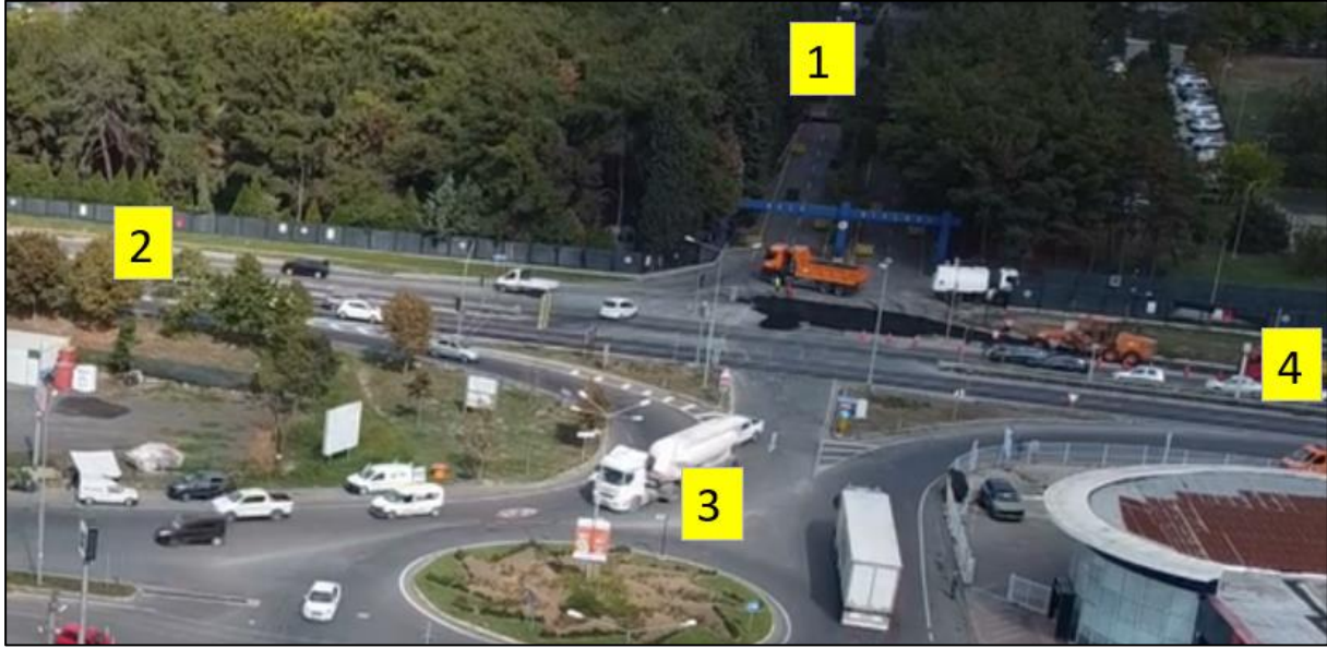
Şekil 33. Ağır Bakım Kavşağı Yaklaşım Kolları Görüntüsü-2
