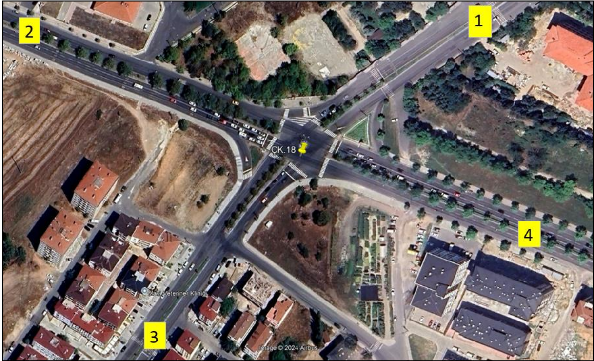
Şekil 107. Ali Kayan İÖO Kavşağı Yaklaşım Kolları Görüntüsü-1
