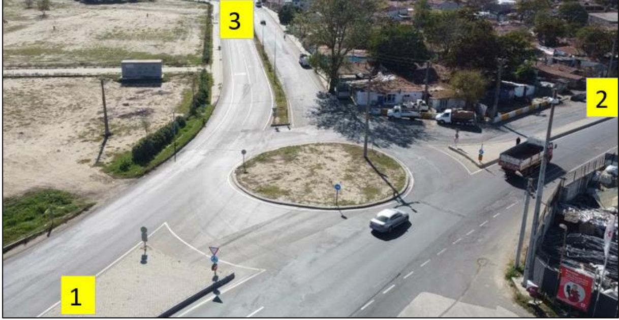
Şekil 93. Çerkezköy Giriş Kavşağı Yaklaşım Kolları Görüntüsü-2
