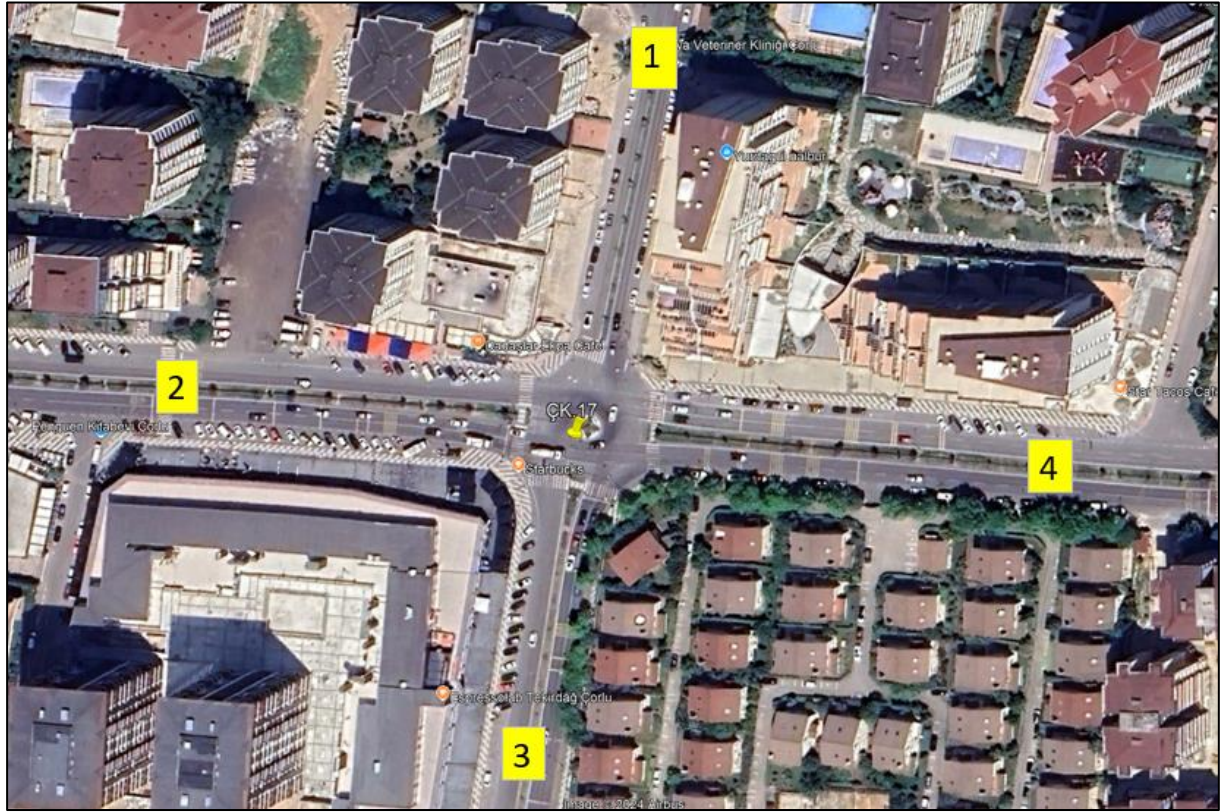
Şekil 102. Çamlıbel Kavşağı Yaklaşım Kolları Görüntüsü-1
