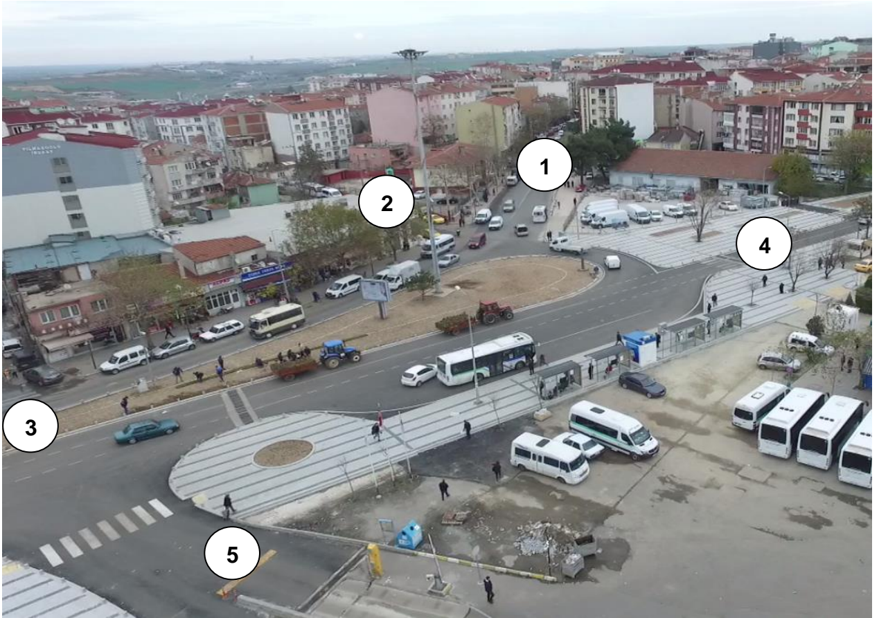
Şekil 2.22. ÇK17.01 Kavşağı İHA görüntüsü ve kollar
