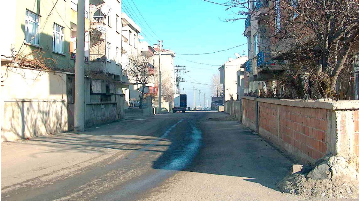
Foto-2.16 Planlı Konut Alanlarında Kaldırımı Olmayan Yollar
