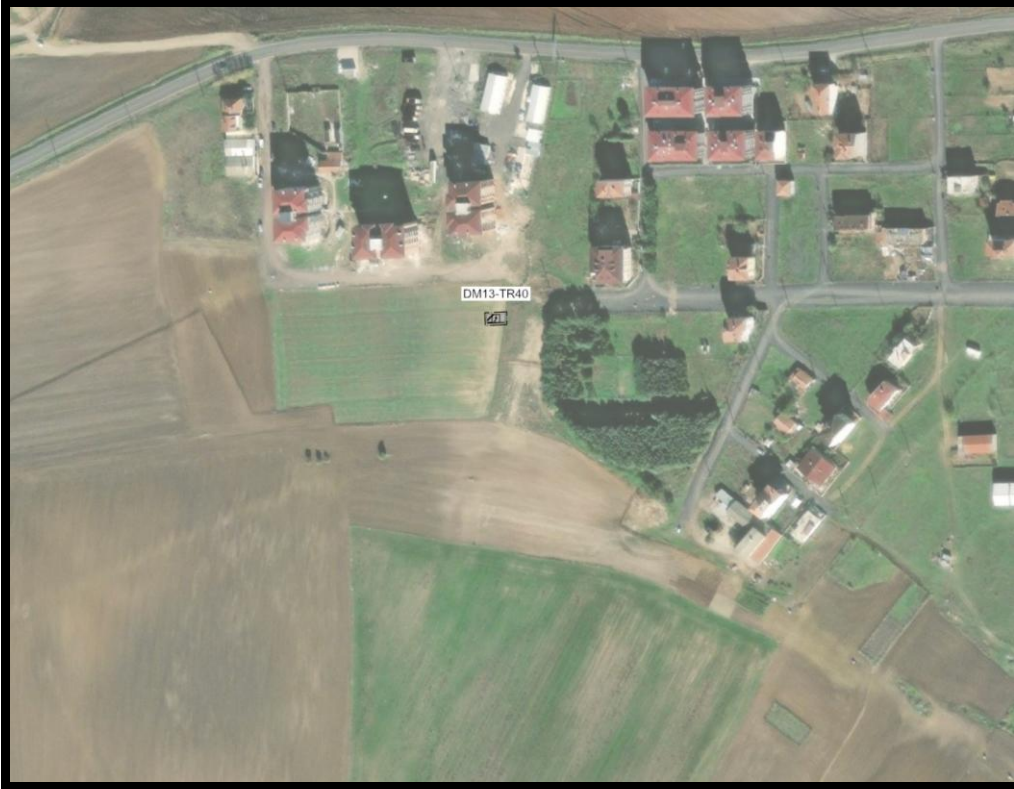
Şekil 3 – Seyhsinan Mahallesi, DM13-TR40 Trafo Alanının Yakın Uydu Görüntüsü
