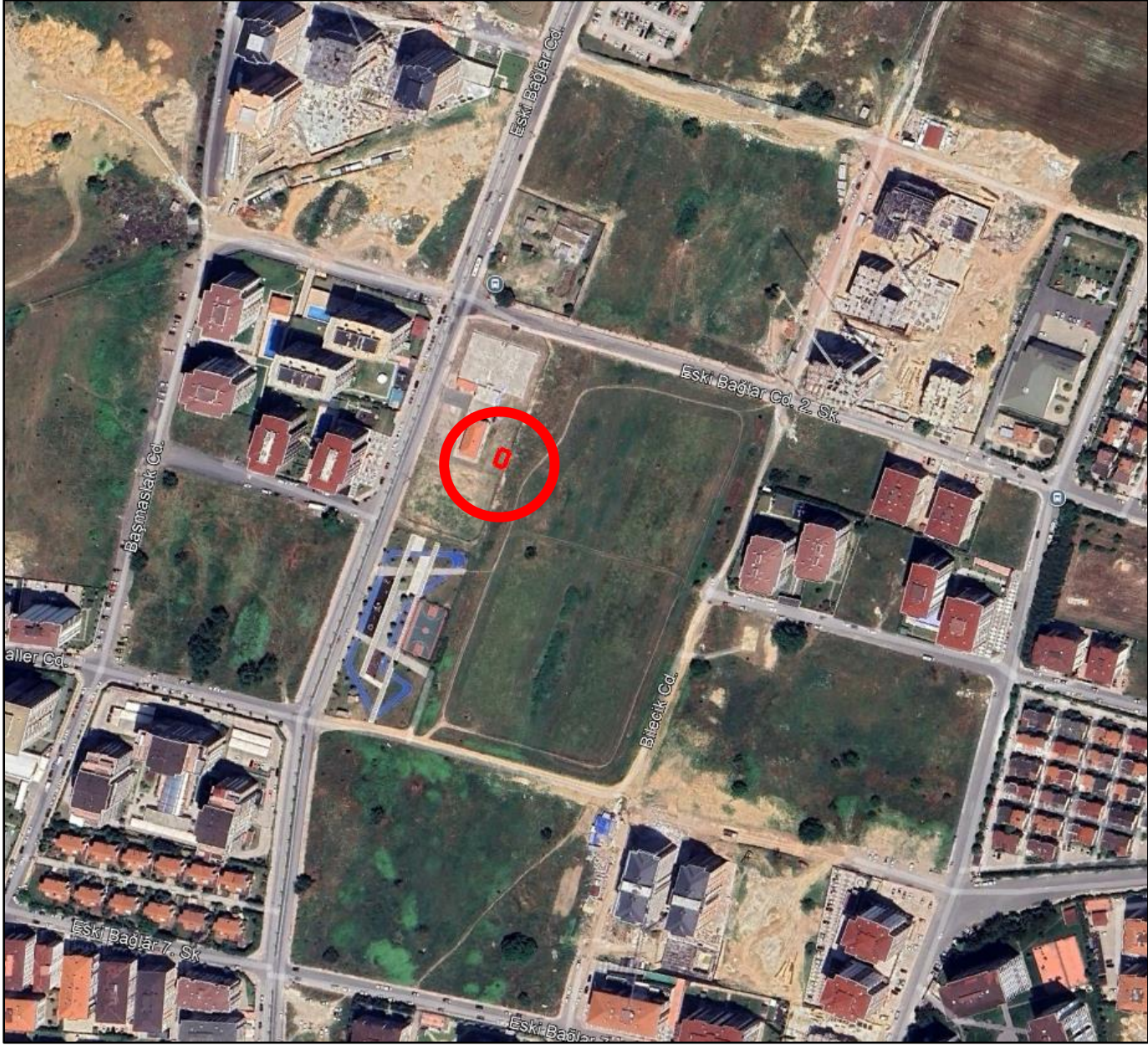
Şekil 1: DM02-TR06 rumuzlu trafonun konumu
