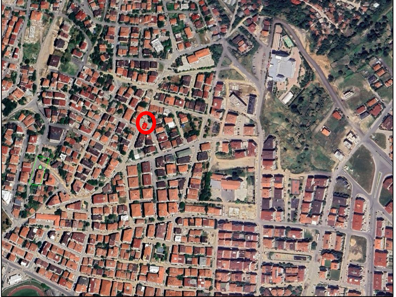
Şekil 2: DM01-TR51 rumuzlu trafonun konumu
